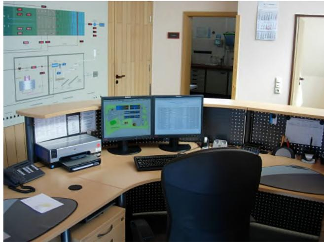
Des Weiteren hat das Leitsystem für den Betrieb der gesamten Abwasseranlagen ein Alarmsystem das 24 Stunden in Betrieb ist und sofort einen Mitarbeiter über das Betriebshandy alarmiert, sobald eine Störung auf der Kläranlage oder den Pumpstationen auftritt. Die auflaufenden Störungen werden durch das Alarmsystem dokumentiert.
