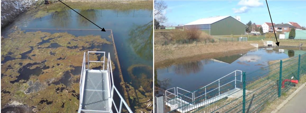
Die Schwimmsperre auf der Wasseroberfläche dient dazu Stoffe die leichter sind als Wasser, wie z.B. Öle, aufzuhalten.
