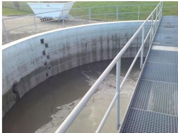
Das zweite Ausgleichsbecken ist funktionstechnisch gleich mit dem ersten. Dieses Becken wird ab einer bestimmten Füllmenge des Ausgleichsbecken 1 direkt über einen Überlauf gefüllt. Damit wird die Pufferkapazität nochmal enorm vergrößert.
