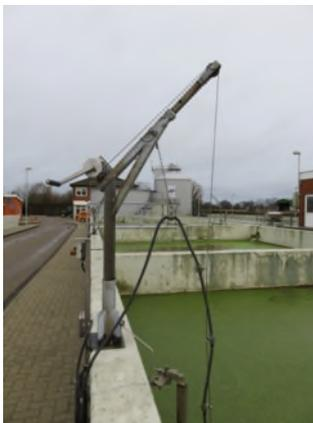
Winde an denen die Rührwerke in die Denitrifikationsbecken gelassen werden.
