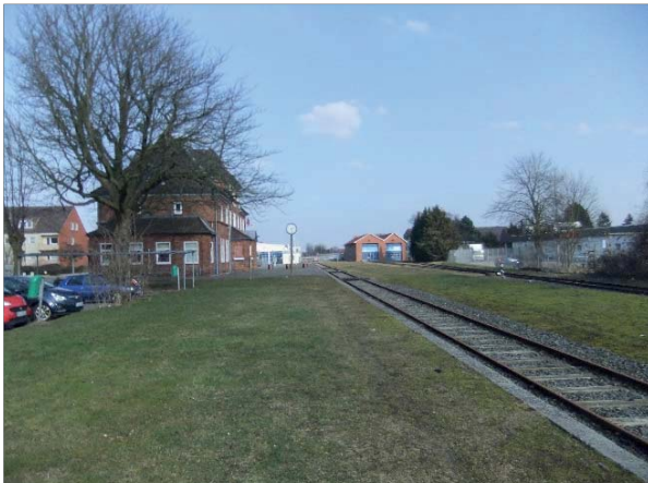
Abbildung 56: Zurzeit inaktiver Bahnhof Schönberg; Quelle: eigene Aufnahme.
