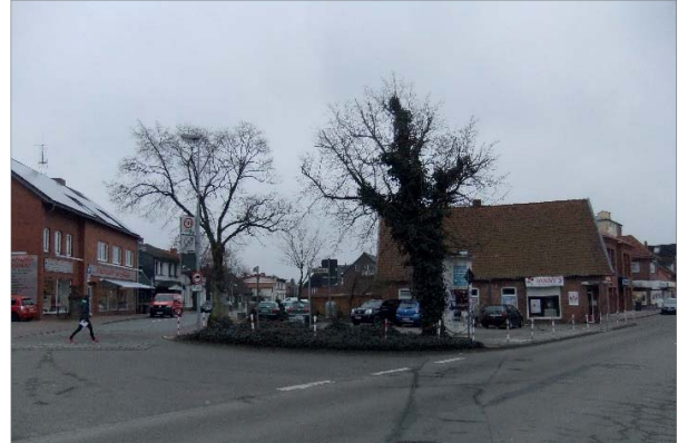
Abbildung 36: Mangelhafte Platzgestaltung im Ortsteil Schönberg, Quelle: eigene Aufnahme.
