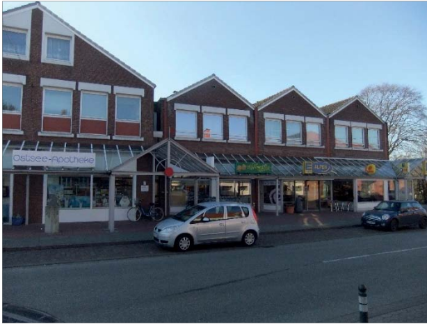
Abbildung 62: Einzelhandelsbereich in der Bahnhofstraße, Ortsteil Schönberg; Quelle: eigene Aufnahme.
