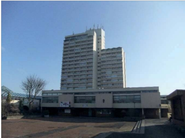
Abbildung 16: Rückseitiger Blick auf das Hochhaus und die Ladenzeile, Quelle: eigene Aufnahme.
