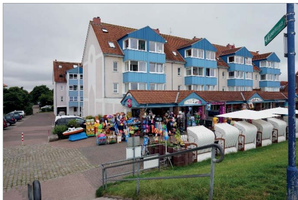
Abbildung 31: Kleinteiliger Einzelhandel entlang der 1.-Reihe-Bebauung; Quelle: eigene Aufnahme.
