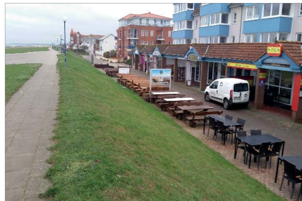
Abbildung 32: Deichkronenweg mit Blick auf die 1.-Reihe-Bebauung; Quelle: eigene Aufnahme.
