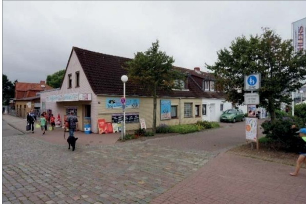
Abbildung 35: Städtebauliche Missstände beeinflussen das Ortsbild im Ortsteil Schönberger Strand, Quelle: eigene Aufnahme.
