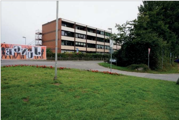
Abbildung 43: Geschosswohnungsbau im Ortsteil Kalifornien; Quelle: eigene Aufnahme.
