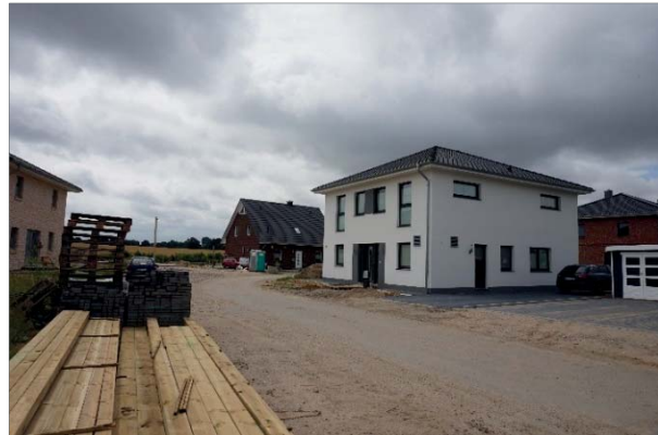
Abbildung 44: Einfamilienhaus im Ortsteil Schönberg; Quelle: eigene Aufnahme.
