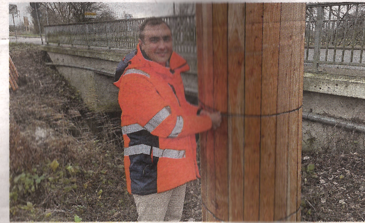
Bauleiter Kilian Feindt prüft die Ummantelung der Bäume an der Kuhbrücksau.
